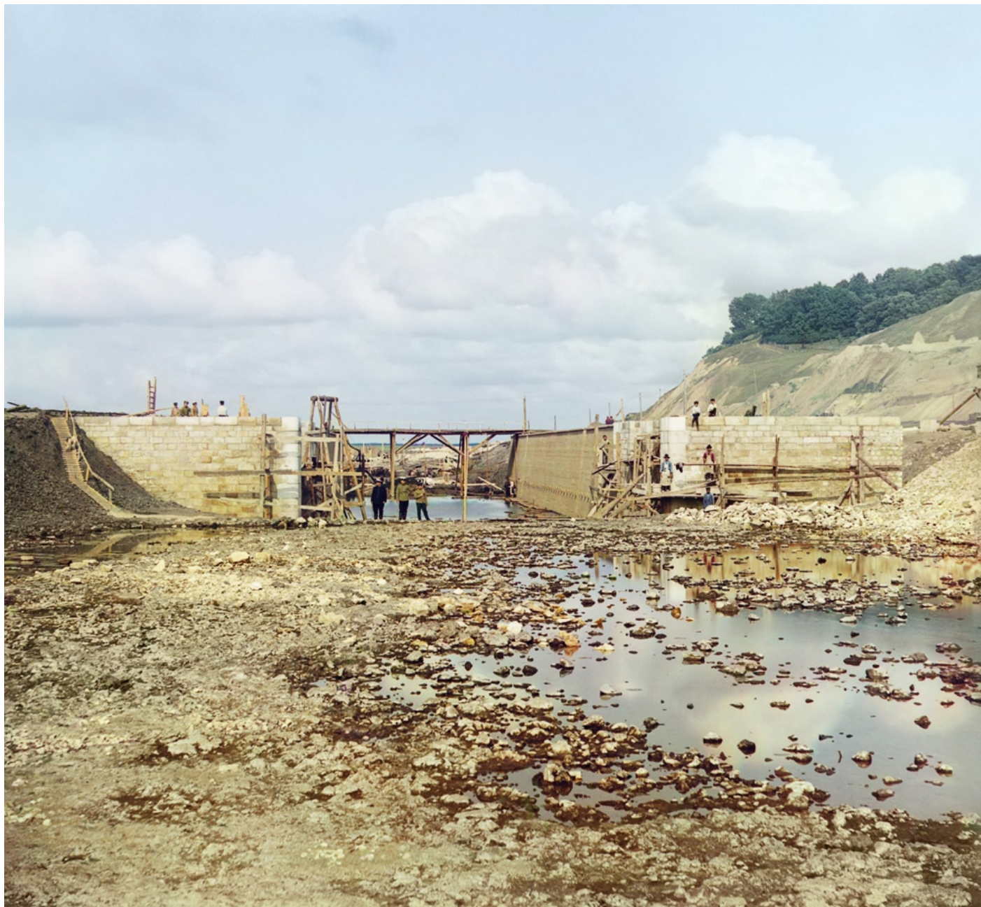
Заканчивающаяся часть шлюза. 1912
