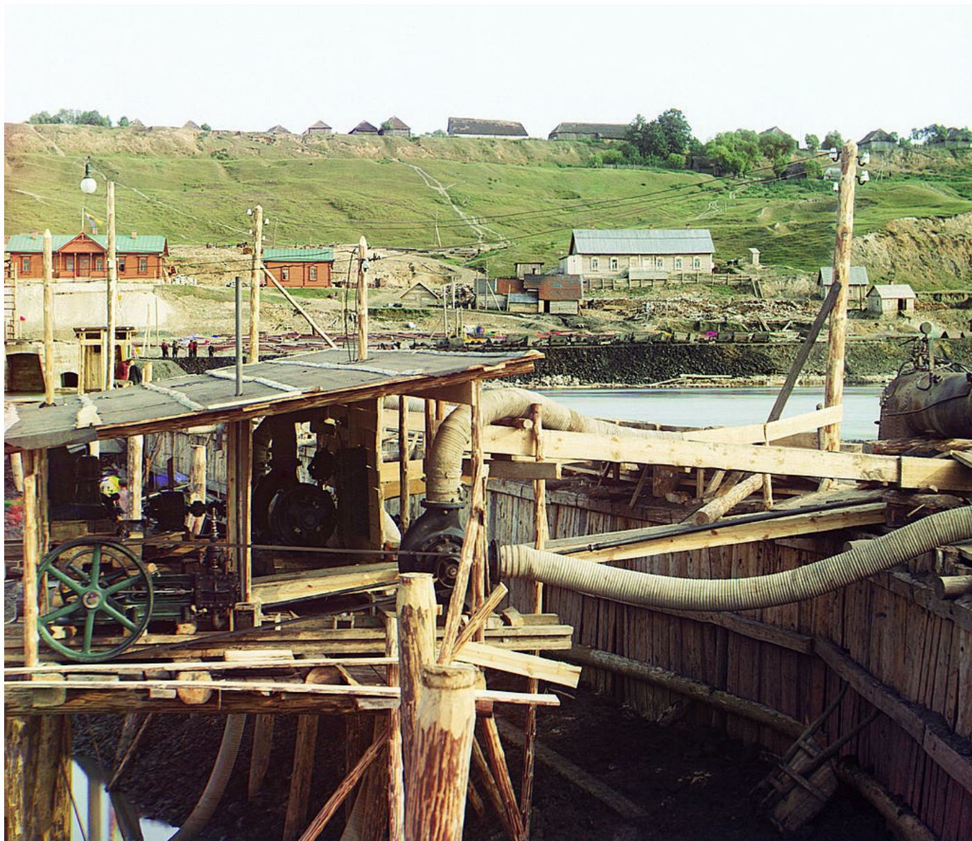
Насосы для откачивания воды. 1912
