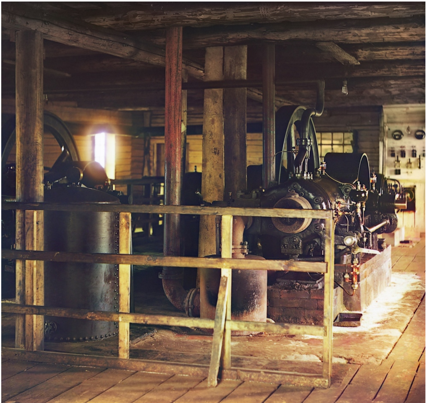
Машинное отделение Кузминской дизельной электростанции. 1912
