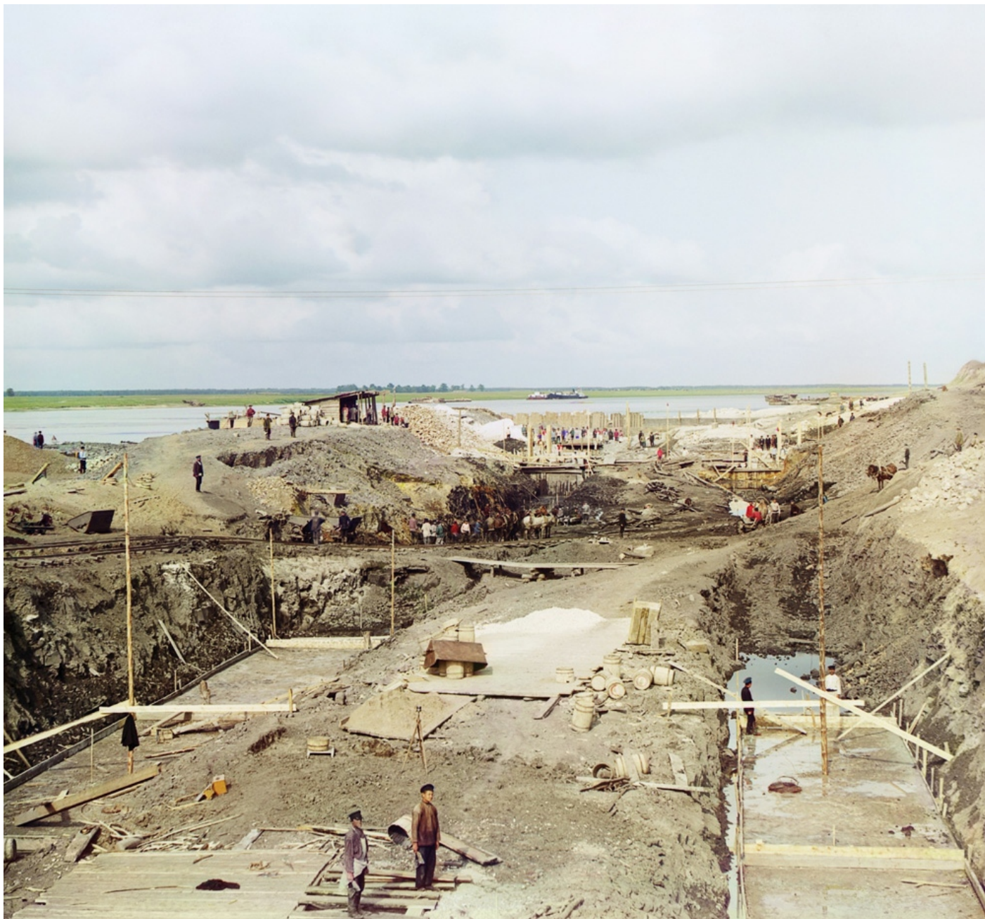
Работы по постройке шлюза. 1912
