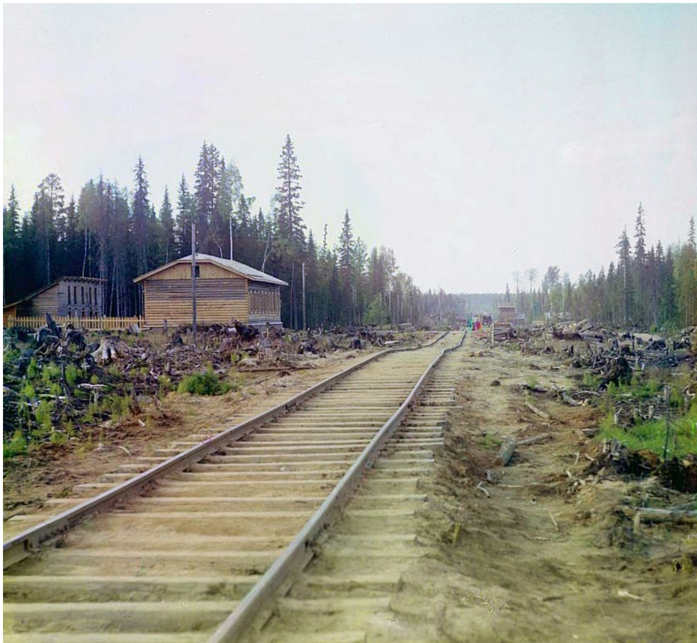
Станция Ладва Олонецкой железной дороги. Неровности пути. 1916
