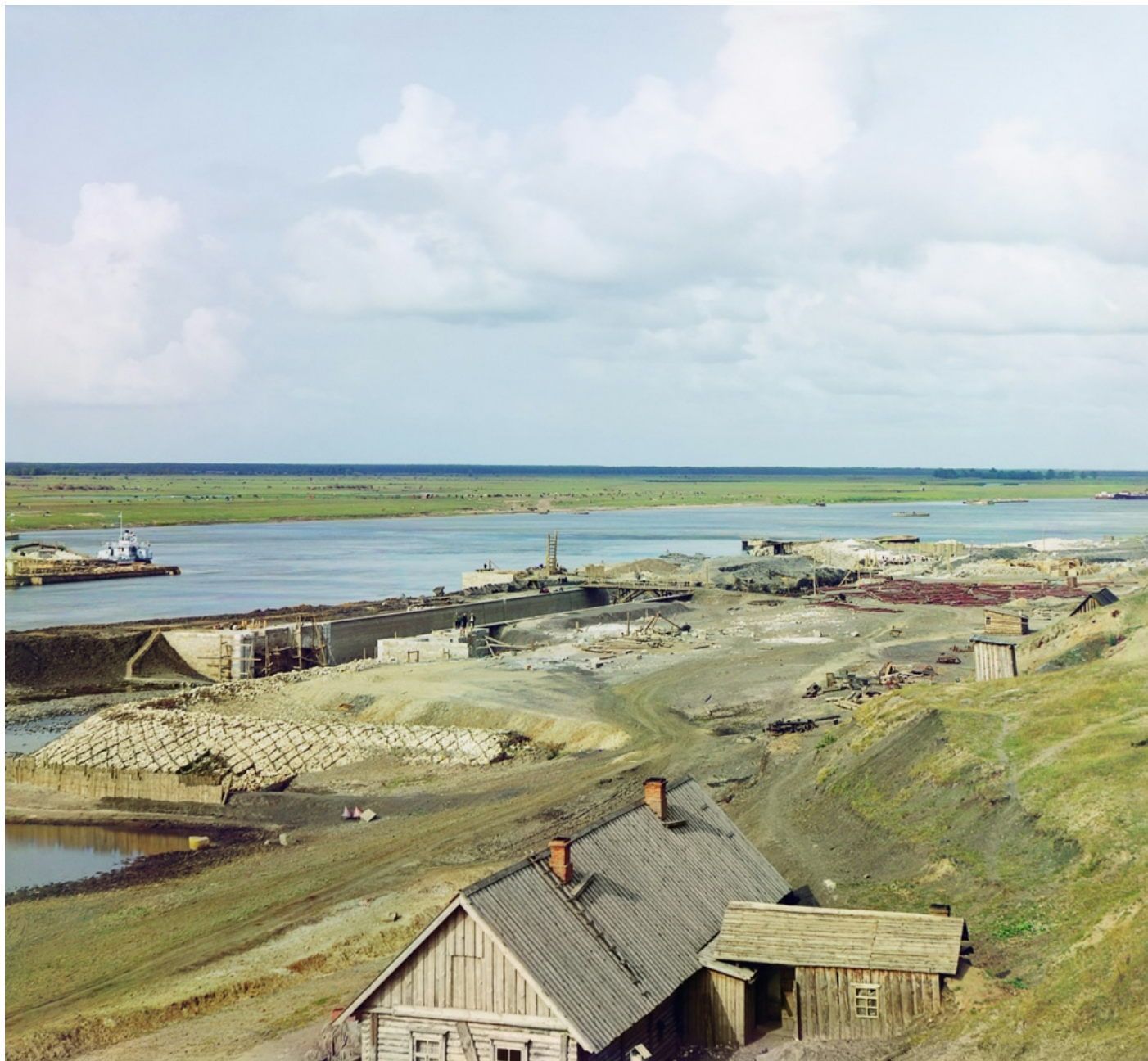
Постройка шлюза близ села Кузминского. 1912
